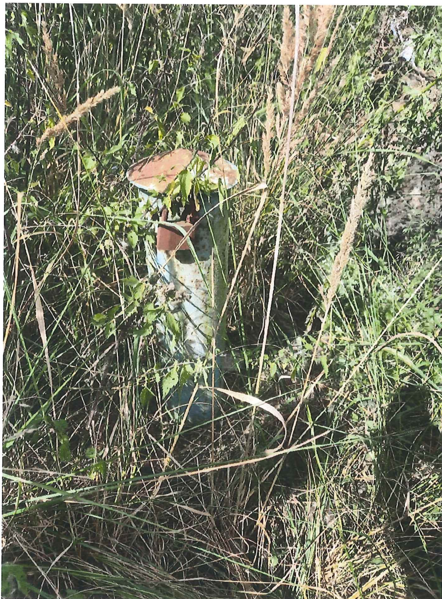
Zdjęcie nr 4 - piezometr obserwacyjny z pokrywą zabezpieczoną kłodką, zlokalizowany po zachodniej stronie składowiska.
